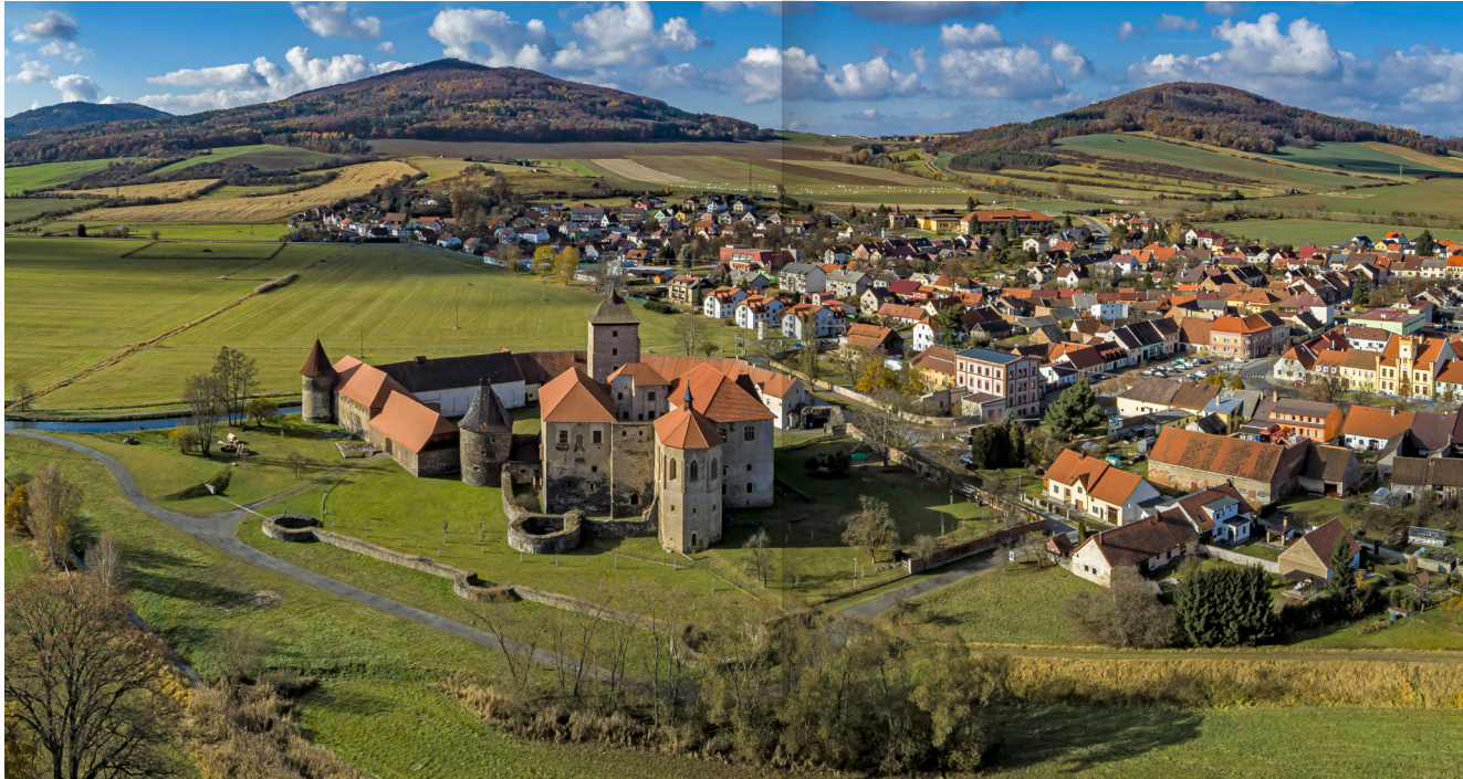
Letecký pohled na Švihov od východu. V pozadí kopce Běleč a Tuhošť.
