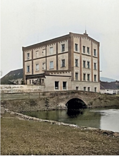
Vodní mlýn s elektrárnou kolem roku 1910
