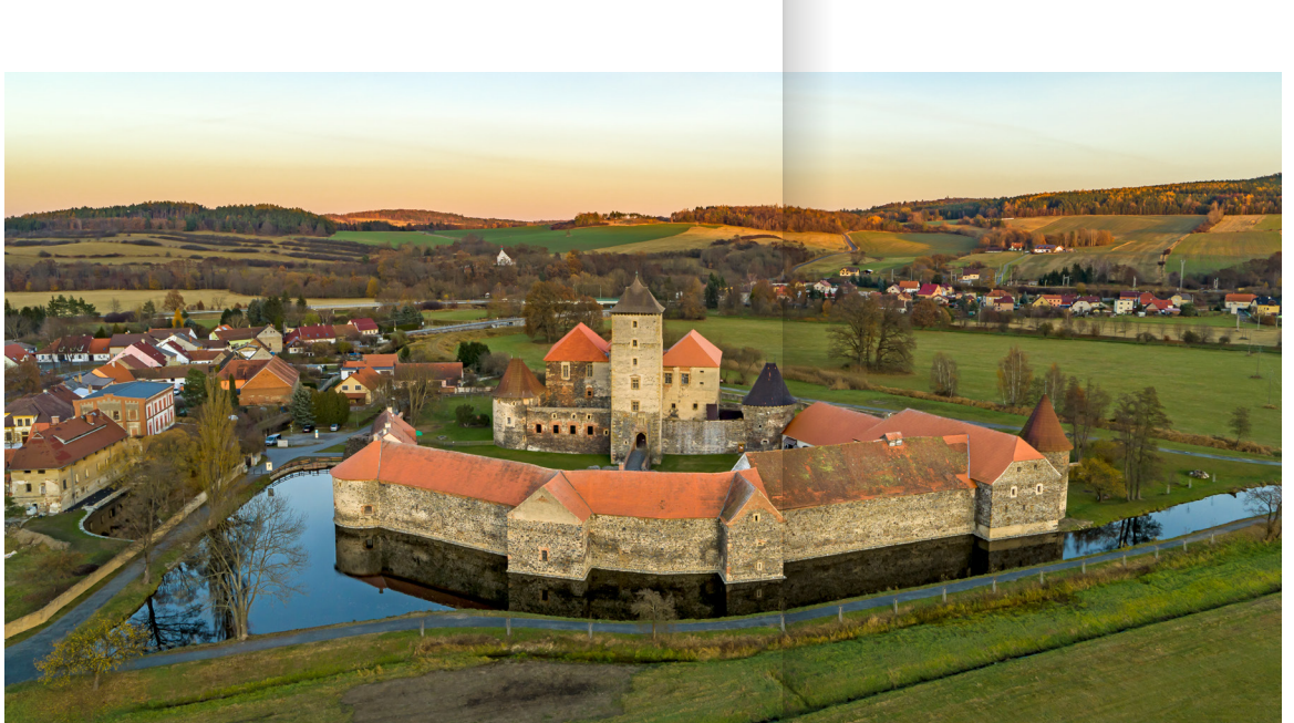
Hrad Švihov s vodním příkopem od západu
